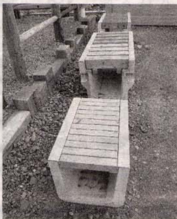
土木用地域材需要拡大協議会で設置した試作品展示場の木製グレーチング
