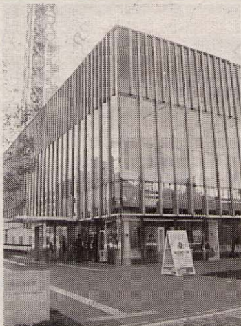
外側には杉の保存処理材を使用
